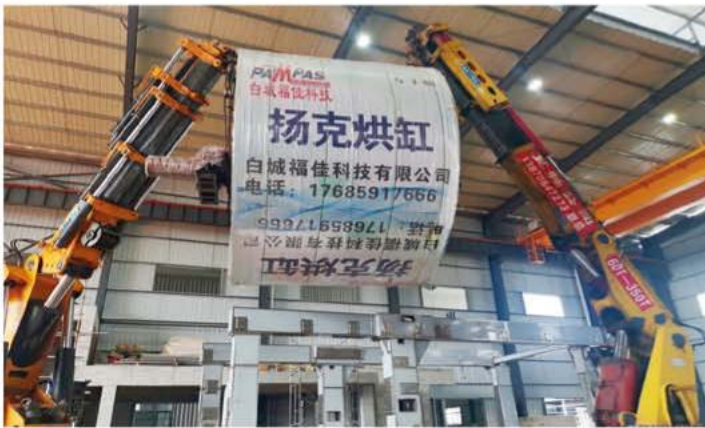
安装中的烘缸直径4877mm
