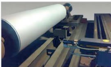
超音速现场喷涂
