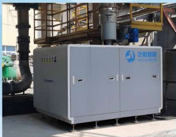
岳阳林纸污水站风机替换项目
