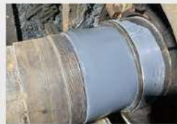
纸机烘缸 轴承位磨 损在线修复
