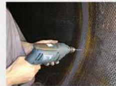
纸机烘缸 轴承位磨 损在线修复
