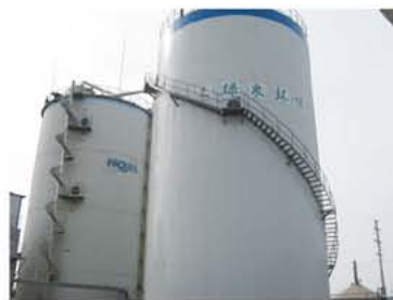
山东世纪阳光纸业2.5万m 3 /d污水处理工程
