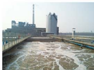
汇胜集团1万m 3 /d污水处理工程
