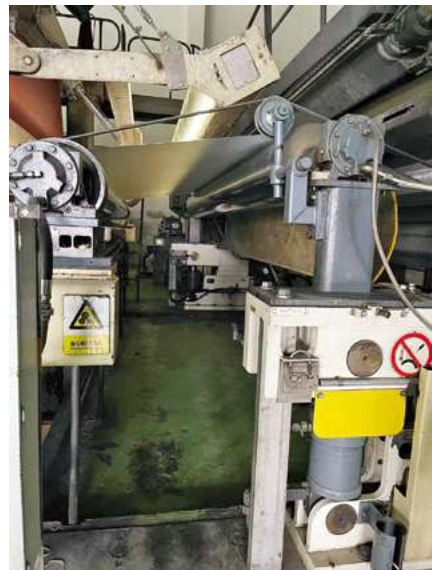
图6 改造后导辊安装位置
