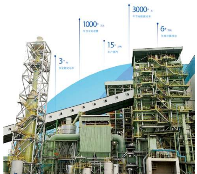
图4 CLVP 1号废渣炉设备工程项目现场
