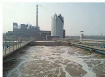
汇胜集团1万m 3 /d污水处理工程
