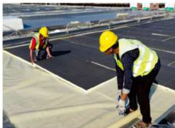
铺设PIR保温板
