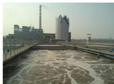
汇胜集团1万m 3 /d污水处理工程
